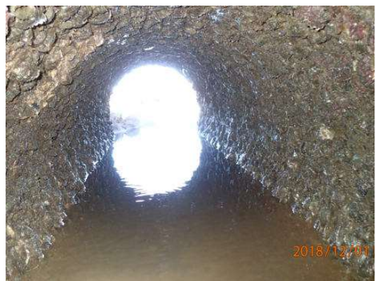
照片 3-2-11 排水孔內部情形
