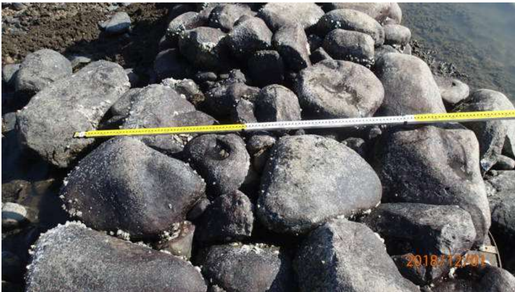
照片 3-2-7 石滬第二區段構造 (a) 石滬頂部
