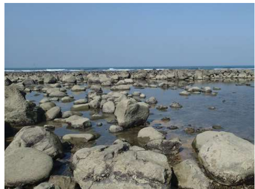
石滬損毀所脫落石塊
