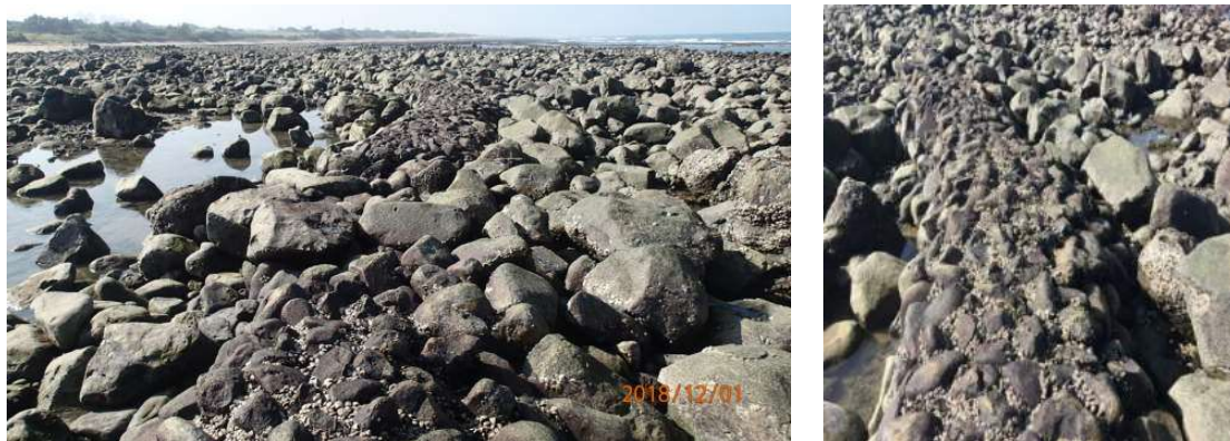
照片 4-5-1 舊有保存完整石滬損壞現況
