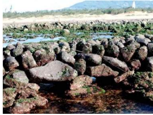
照片 3-1-8 沙崙石滬排水孔
