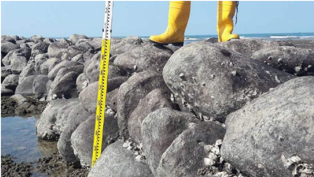
照片 3-2-9 石滬第二區段構造 (c) 石滬高度
